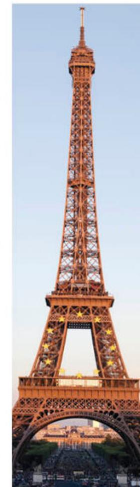
4.36 Cada cinco años se aplican 60 toneladas de pintura para evitar la corrosión de los casi 250 000  $\text{m}^2$  de la estructura de hierro de la Torre Eiffel.
